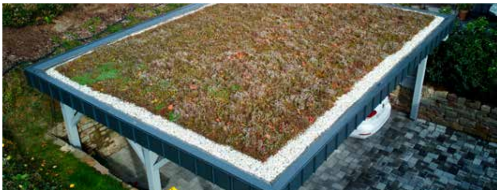
Eine Dachbegrünung ist nicht nur eine optische Bereicherung, sie hilft z. B. Gebäudeunterhaltungskosten zu reduzieren und trägt außerdem effizient zur Feinstaubfilterung bei.
