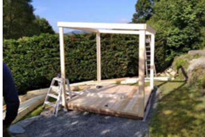
Den Rahmen aufstellen und befestigen.
