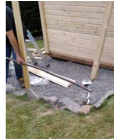
Eindrehen der Erdankerschraube.
