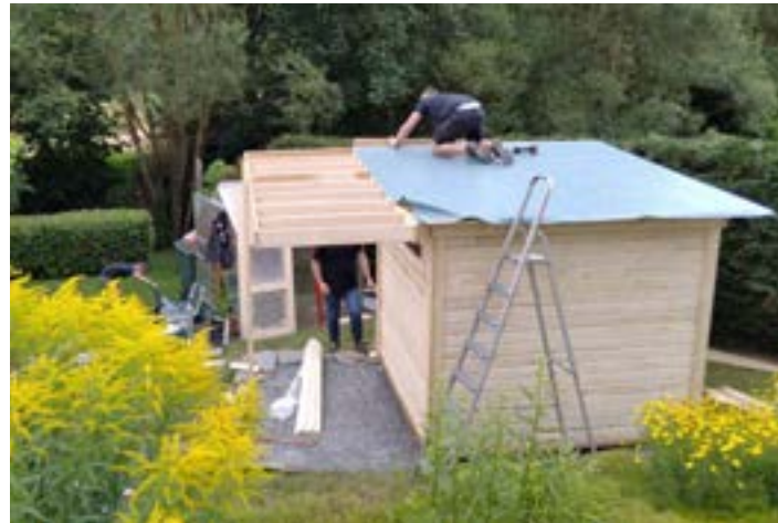
Blendbretter und Dachfolie befestigen.
