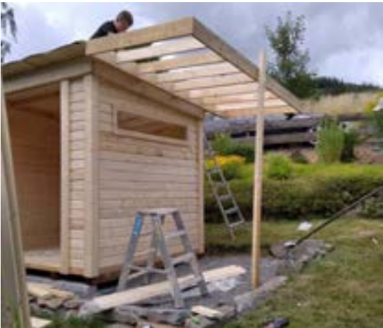
Anbau-Konstruktion mit Haus verbinden.
