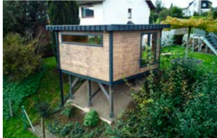
Unterkonstruktion vom Kunden in Eigenleistung.
