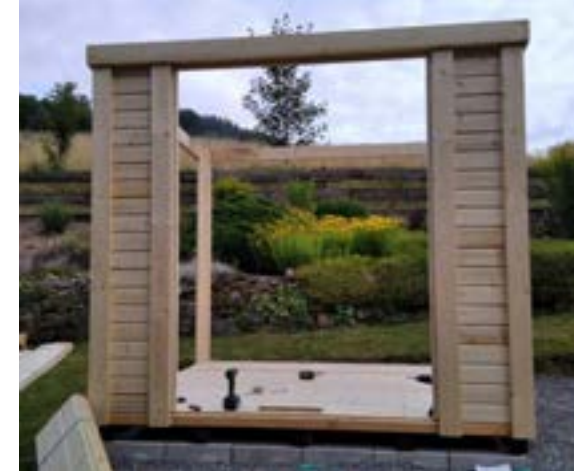
Die Wandbohlen zusammenstecken und verschrauben.
