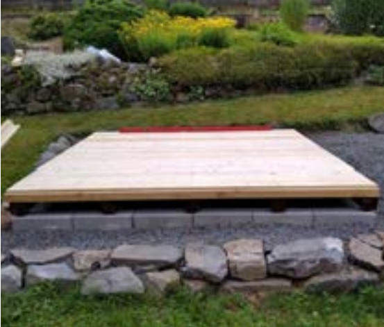
Den Boden in Waage auslegen und verschrauben.
